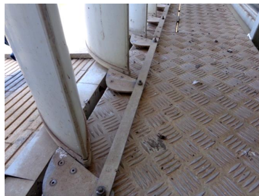
Figura 62 – Sistema de brise soleil. Peças superiores de transmissão de movimento em um dos módulos de lamelas, vistas de baixo para cima. Observar moto-redutor pivotante, braço de acionamento, guia de movimentação superior, abas das tampas superiores, lamelas (BRASIL. SENADO FEDERAL, 2013).
