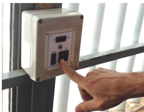
Figura 59 – Sistema de brise soleil. Central de comando e botoeira (BRASIL. SENADO FEDERAL, 2013).
