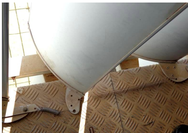
Figura 64 – Sistema de brise soleil. Observar, ao centro, que a aba inferior que se projeta da lamela não está ligada à guia de movimentação, mas sim a duas molas. Assim, ela tem movimento individualizado – não se move em conjunto com nenhum dos módulos vizinhos (BRASIL. SENADO FEDERAL, 2013).
