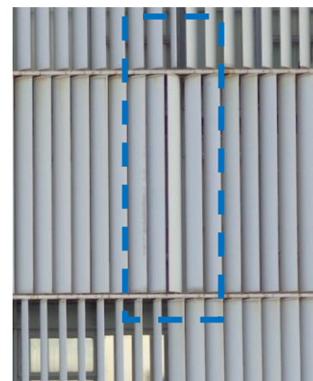
Figura 64 – Sistema de brise soleil. Observar, ao centro, que a aba inferior que se projeta da lamela não está ligada à guia de movimentação, mas sim a duas molas. Assim, ela tem movimento individualizado – não se move em conjunto com nenhum dos módulos vizinhos (BRASIL. SENADO FEDERAL, 2013).
