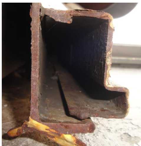
Figura 54 – Perfis utilizados na Fachada Sul da torre sul. Comparar a chapa #14 do montante principal (esquerda) com a chapa #16 do perfil da direita. Fotografia: DETEC/CD, 2013. (MACEDO, LIMA, & SILVA, Aço e alumínio nas fachadas na Câmara dos Deputados, 2013)
