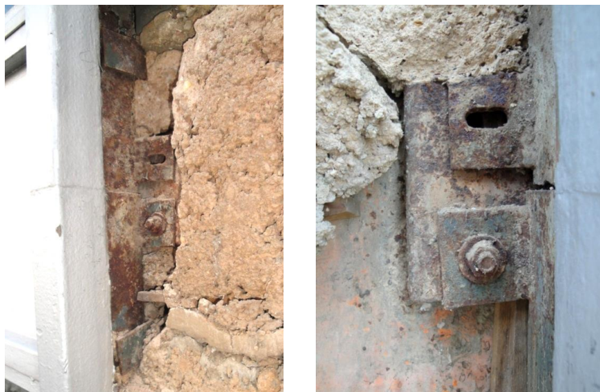
Figura 40 - Fixação dos montantes à laje, fachada sul, torre sul. Observar: junta entre dois montantes, ao centro; fixações com orifícios e parafusos, ao centro; fixações do tipo garfo, nas partes superior e inferior (MACEDO, LIMA, & SILVA, Aço e alumínio nas fachadas na Câmara dos Deputados, 2013).
