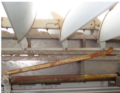
Figura 62 – Sistema de brise soleil. Peças superiores de transmissão de movimento em um dos módulos de lamelas, vistas de baixo para cima. Observar moto-redutor pivotante, braço de acionamento, guia de movimentação superior, abas das tampas superiores, lamelas (BRASIL. SENADO FEDERAL, 2013).
