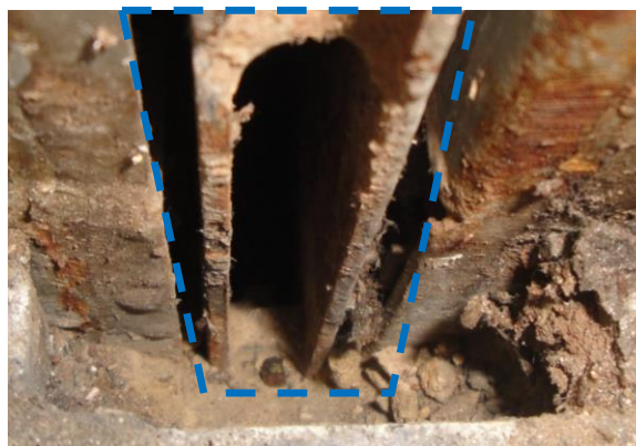
Figura 42 - Fixação dos montantes à laje, fachada sul, torre sul. Face do montante voltada para o interior da edificação vista de cima para baixo. Parte do montante (azul) parece se engastar na laje, o que configuraria forma alternativa de apoio (MACEDO, LIMA, & SILVA, Aço e alumínio nas fachadas na Câmara dos Deputados, 2013).
